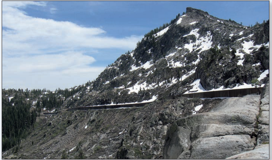
Снег у перевала Доннер. Видна противолавинная галерея первой в мире трансконтинентальной железной дороги (в настоящее время пути внутри нее разобраны)
